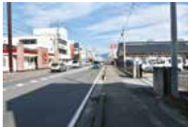
第1中継所:伊那市保健センター
